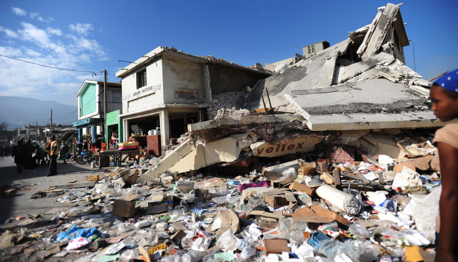
Un bâtiment effondré, après le tremblement de terre à Port-au-Prince, Haïti. Photo credit © Julie Remy, 2010
